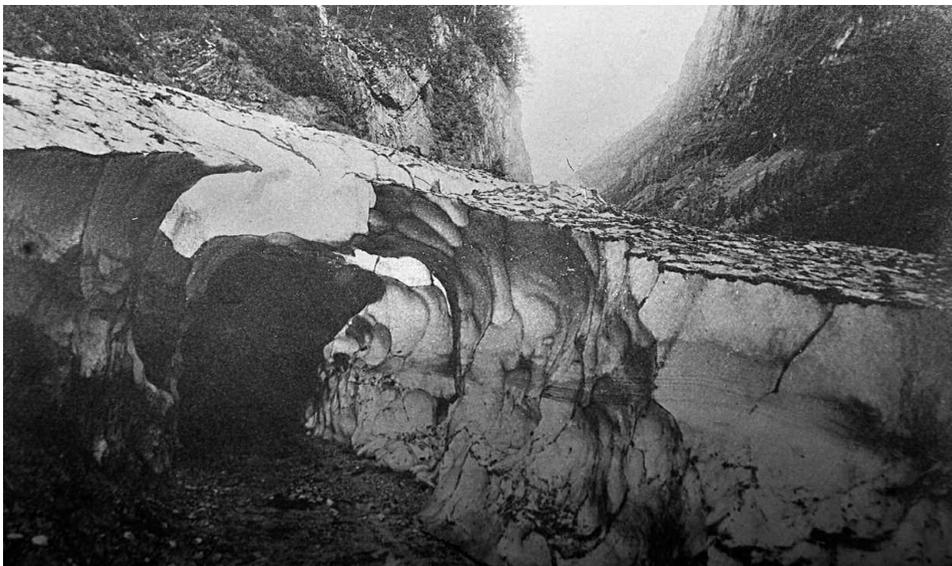
**Lawinentunnel:** Um im Vorsommer einen Zugang nach St. Martin und zu den Alpen im hinteren Calfeisental zu ermöglichen, mussten zuerst solche Tunnels durch die Lawinenkegel gegraben werden.
