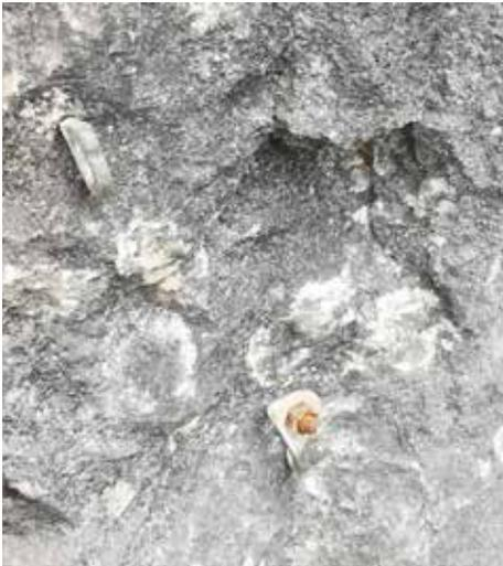
Stift-, korrodierter Anker- sowie Kronenbohrhaken (Föhnmauer, Fläsch)
